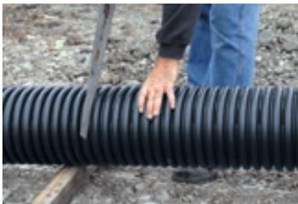
Die Rohre sind mit einer feinzahnigen Säge oder einem anderen geeigneten Werkzeug mittig im Wellental und senkrecht zur Rohrachse abzulängen.
