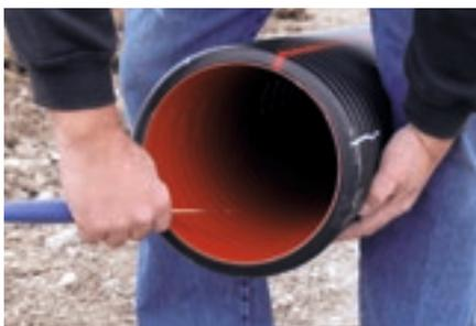
Grate und Unebenheiten der Trennflächen sind mit Schaber, Feile bzw. sonstigem geeigneten Werkzeug zu entfernen.
