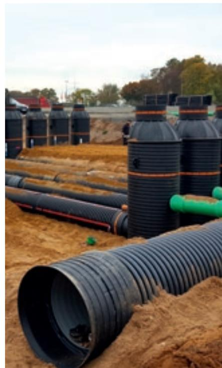
Die DIBt-zugelassenen Systeme Sedi-Substrator und Rigofill inspect reinigen künftig das Oberflächenwasser an der Tank- und Rastanlage Nievenheim-Ost, speichern es und lassen es anschließend kontrolliert versickern. Damit schützt die unterirdische Versickerungsanlage mit Sedimentationsstrecke von FRÄNKISCHE das Grundwasser an der A57, einer der Verkehrs-Hauptschlagadern am Niederrhein – mit hoher Reinigungsleistung bei geringem Platzbedarf.
