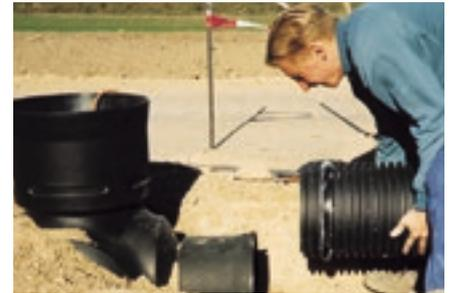
Der Einbau ist durch das geringe Gewicht problemlos. Die passenden Zubehörteile erfüllen alle Anforderungen an die praxisgerechte Sickerleitungs-technik.
