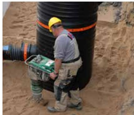
Beispiel: Zielschacht in Verbindung mit Rigofill-Rigole
