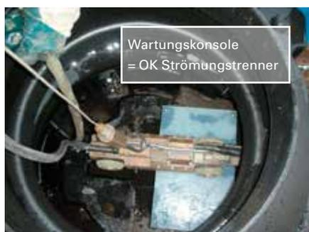
Kontrolle des Spülerfolges mit Dreh-Schwenkkopf-kamera, Kamera auf der Wartungskonsole im Startschacht einer SediSubstrator XL - Anlage
