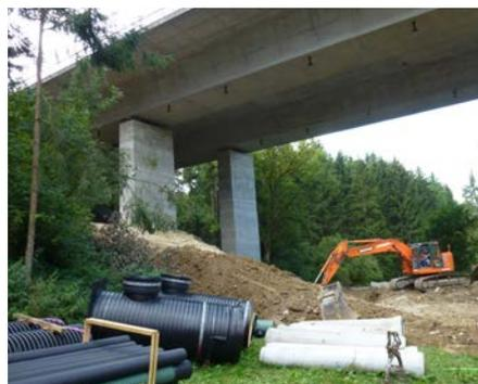
Im Rahmen der Straßenentwässerung an der A 81 galt es, eine Lösung für den Umgang mit belastetem Regenwasser zu finden.
