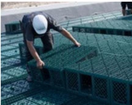
Entsprechend der Planung sind die Rigofill inspect Blöcke auf dem Planum auszulegen. Sie sind so aneinanderzureihen, dass sich die geplanten Rigolentunnel ergeben. Der Einbau bei Frost erfordert grundsätzlich höhere Sorgfalt (Schlagempfindlichkeit, siehe Hinweise im Abschnitt Transport und Lagerung).
