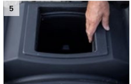
Anschließend ist der Schachtkörper von Spänen zu säubern. Die entstandenen Abschnitte sind ordnungsgemäß zu entsorgen.
