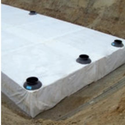
Rigofill inspect Anlagen sind vollständig mit Vlies (RigoFlor) zu umhüllen. QuadroControl - Schächte sind als Bestandteil der Rigolen-Kubatur ebenfalls mit zu umhüllen. An den Stößen sind ausreichende Überlappungen (mind. 50 cm) herzustellen, damit kein Verfüllmaterial in die Anlage gelangen kann. Rohreinführungen sind durch kreuzförmiges Einschneiden des Vlieses sanddicht herzustellen.
