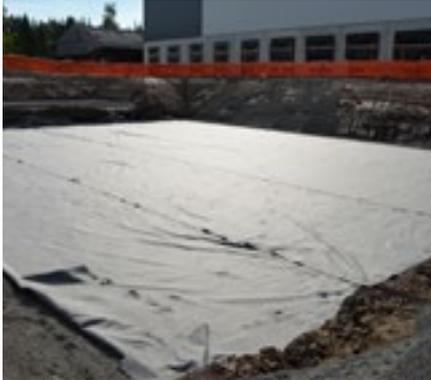
Die gesamte Rigole ist mit RigoFlor Rigolenvlies zu umhüllen. Vor der Verlegung der Blöcke ist das Vlies auf dem Planum auszulegen. Das Vlies muss seitlich genügend Überstand haben, damit anschließend die gesamte Anlage umhüllt werden kann.
