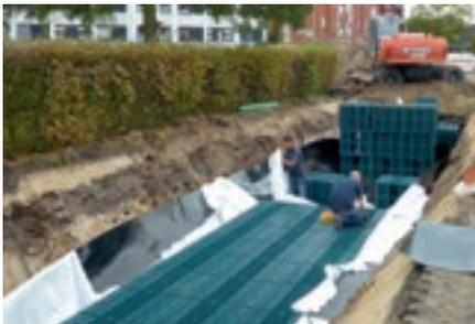
Für den Einsatz von Rigofill inspect zur Regenwasserspeicherung kann die Anlage mit einer Kunststoff-Dichtungsbahn (KDB) ummantelt werden. Neben dieser Einbauanleitung sind zudem die Vorgaben des Herstellers der Kunststoff-Dichtungsbahn (KDB) zu deren Einbau zu beachten.
