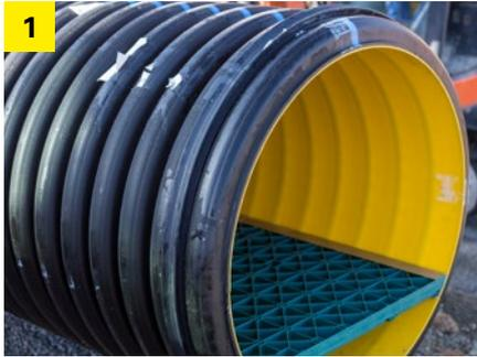
1 Noch außerhalb der Baugrube sind die Profildichtringe im jeweils ersten Wellental aufzuziehen. Das Rohr muss sauber sein.
