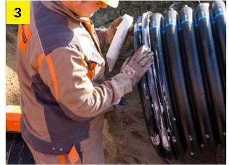
3 Rohr, Dichtring und Muffe sind sauber zu halten. Anschließend sind Dichtring und Muffe ausreichend mit Gleitmittel einzustreichen. Es ist darauf zu achten, dass keine Verschmutzungen im Dichtbereich anhaften. Im Bereich der Doppelsteckmuffen ist die Bettung entsprechend zu vertiefen. Damit der Profildichtring nicht auf dem Bettungsmaterial aufliegt, kann das zu montierende Rohrende auf ein Kantholz aufgelegt werden.
