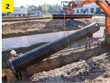
2 Das Sedimentationsrohr ist mittels Hebezeug in Einbauposition zu bringen. Die Scheitelmarkierung muss oben sein. Der im Rohr eingebaute Strömungstrenner liegt dabei unten.
