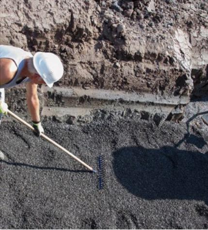
Zur Herstellung der Baugrube und der unteren Bettung für SediPipe level sind neben den Bestimmungen aus der DIN EN 1610 auch die Vorgaben der DIN 18300 „Erdarbeiten“, in der jeweils gültigen Fassung, zu beachten.
