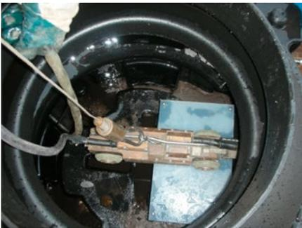
Kontrolle des Spülerfolges mit Dreh-Schwenkkopf-kamera, Kamera auf der Wartungskonsole im Startschacht einer SediPipe level - Anlage
