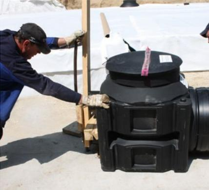
Der zweite Schacht ist auf das vorbereitete Planum höhengerecht aufzusetzen. Danach ist die Muffenverbindung vorzubereiten und der Schacht auf das Sedimentationsrohr zu schieben. Zu- oder Ablaufleitung ist gemäß Planungsvorgabe anzuschließen (siehe Punkt 4.5).
