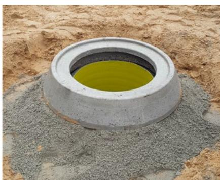
Es sind Schachtabdeckungen nach DIN EN 124, LW 610, Ausführung nach Planungsvorgabe, einzubauen. Unter der Schachtabdeckung / Einlaufrost können optional Ausgleichsringe nach DIN 4034 auf den BARD-Ring gesetzt werden. Die Schachtabdeckung bzw. Ausgleichsring(e) sind auf eine 1 cm dicke Mörtelfuge zu setzen, um Punktlasten zwischen BARD-Ring, Ausgleichsring und Schachtabdeckung zu vermeiden.
