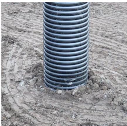
Die Aufsetzrohre sind so zu kürzen, dass sie im Bereich des Auflagerings enden. Die Rohre sind mit einer feinzahnigen Säge oder einem anderen geeigneten Werkzeug mittig im Wellental und senkrecht zur Rohrachse abzulängen.
