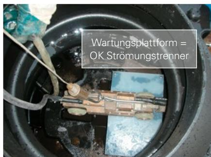
Kontrolle des Spülerfolges mit Dreh-Schwenkkopf-kamera, Kamera auf der Wartungskonsole im Startsegment einer SediPipe-Anlage
